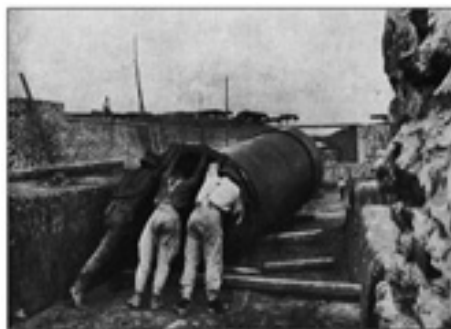
Un tubo di aspirazione da mille millimetri per le pompe dell'Idrovora in L. Bertarelli, Terra promessa , [1922], p. 41
