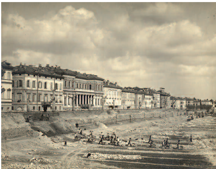
Ferruccio Sorgato e F.llo, Modena, abbattimento delle mura, 1911 , negativo su vetro Archivio Panini / Modena, Fondazione Fotografia
