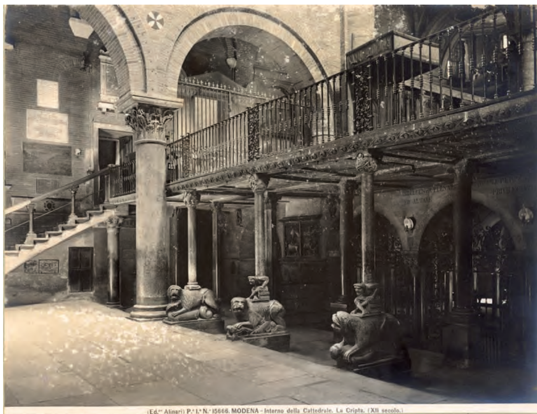
Modena, Duomo, Pontile con ringhiera in ferro e pavimentazione precedente ai lavori di restauro, positivo, gelatina a sviluppo. Modena, Fondazione Fotografia, Fondo Giuseppe Panini
